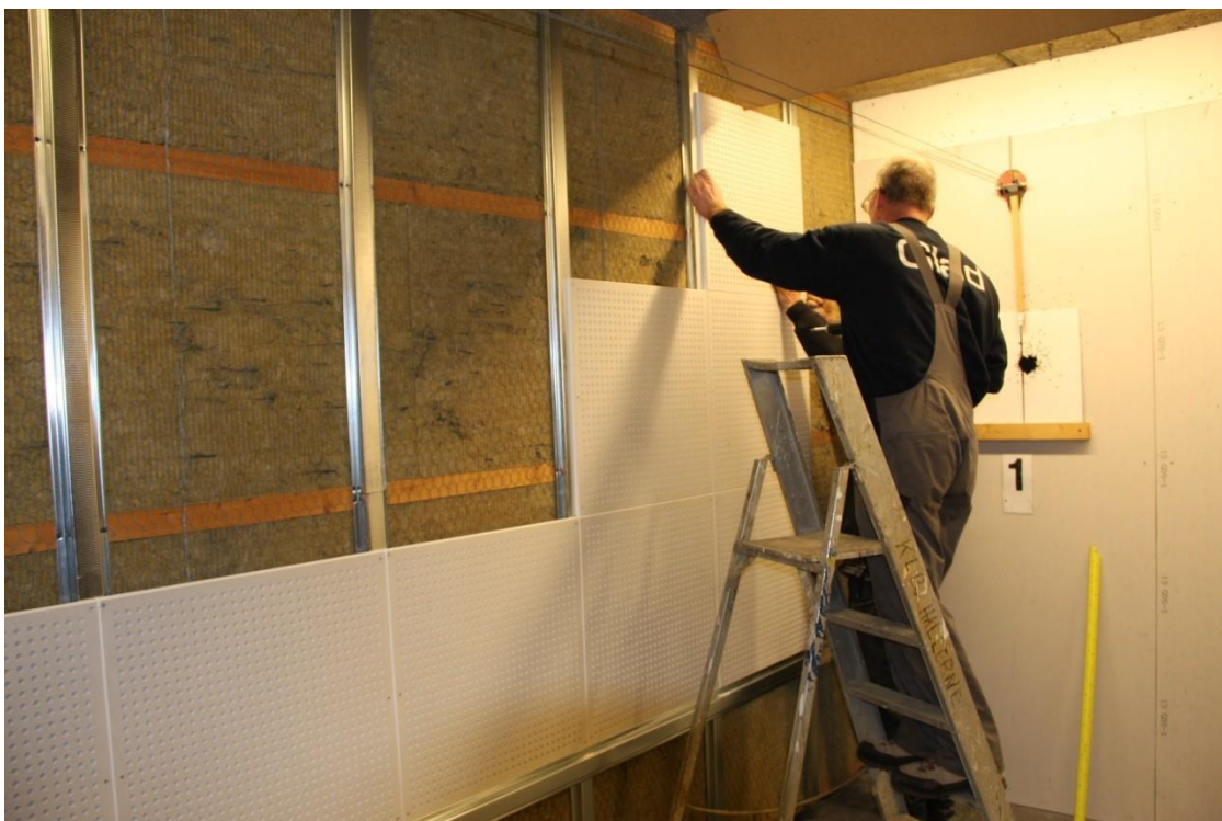
Montering af Gyptone akustikplader
